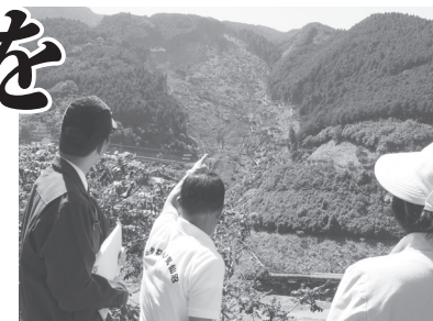
奈良県川上村の「深層崩壊」現場を調査する宮本岳志衆院議員（後ろ向き、左端）、奈良の地方議員11月7日
