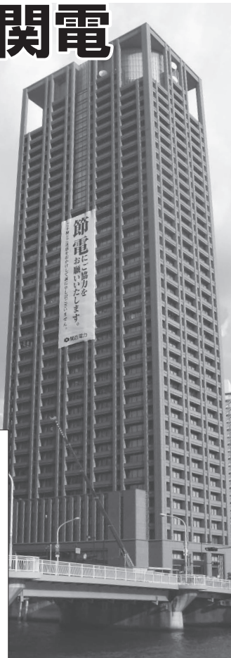
関電本店ビル(大阪市北区)
