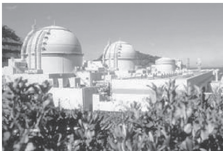
大飯原発3、4号機=手前 (関電ホームページより)
