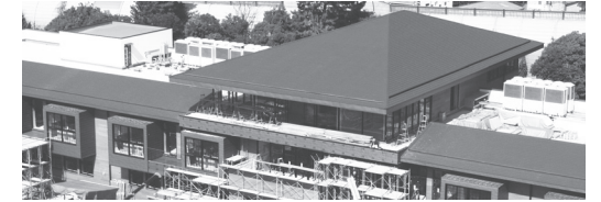
「森友学園」の小学校建設現場=大阪府豊中市
