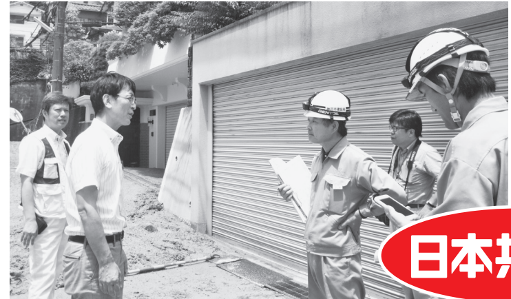
神戸市灘区の住宅近くの土砂崩れ現場で状況を聞く日本共産党の金田峰生、兵庫県国政事務所長、味口俊之・神戸市議 11月8日
