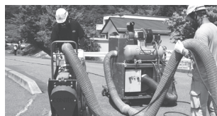
▲放射能除染のため、小学校内のアスファルトの表面を削る作業 = 7月、福島県伊達市
