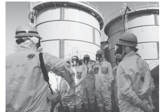
福島第1原発の汚水タンク群を視察する日本共産党視察団(3月9日)
