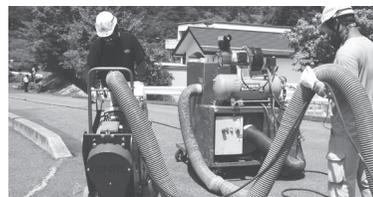
▲放射能除染のため、小学校内のアスファルトの表面を削る作業
