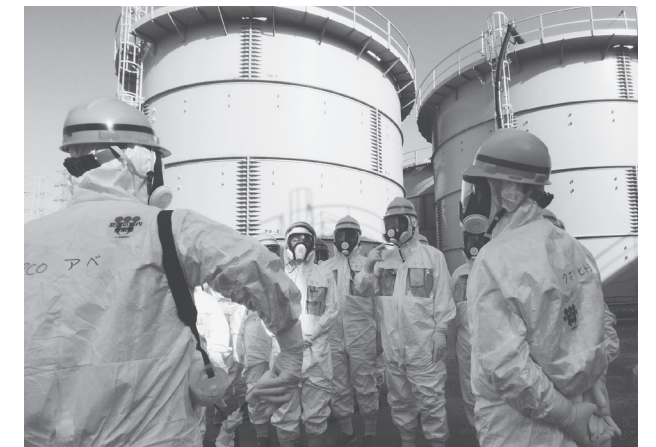
福島第1原発の汚染水タンク群を視察する日本共産党視察団(3月9日)
