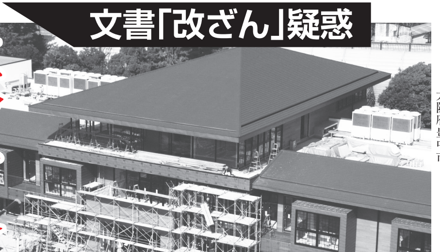
「森友学園」の小学校建設現場 大阪府豊中市
