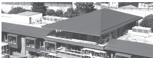
「森友学園の小学校建設現場」大阪府豊中市
