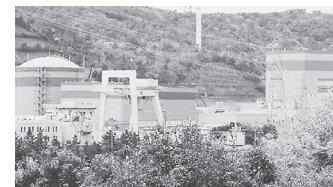
日本原子力発電敦賀原発1号機（左）と2号機（右）=2017年4月20日、福井県敦賀市
