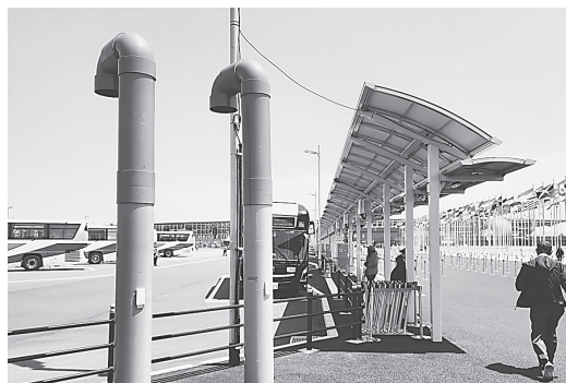
シャトルバス乗り場横に林立するガス抜き管
